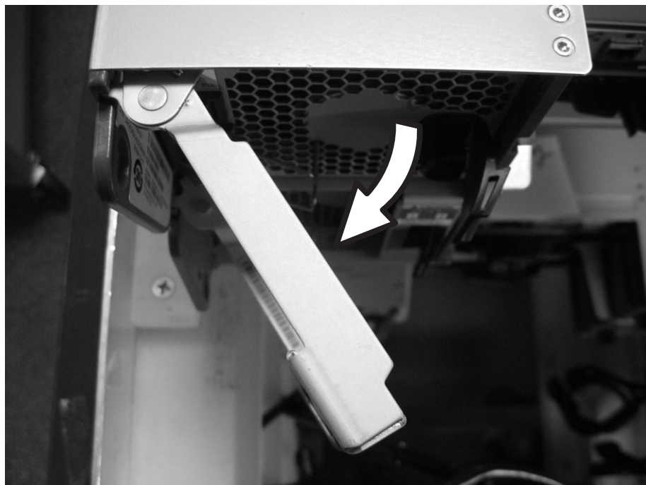
図 13. 電源機構の取り外し
